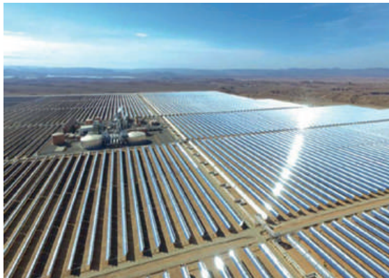
Énergie solaire (Noor Ouarzazate)
