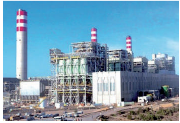
Centrale thermique Jorf Lasfar
